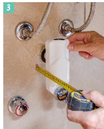
**1.2.** Il tubo di innesto allo scarico a parete è più lungo del necessario e non può essere lasciato tal quale: andrebbe in battuta nella curva di discesa, riducendo la sezione di passaggio, e il sifone rimarrebbe distanziato dalla parete, impedendo di recuperare al meglio lo spazio.
