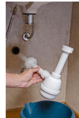
Il sifone tradizionale a bottiglia impedisce di installare nel vano sottolavabo complementi utili come quello della foto, in quanto sarebbe di disturbo per le gambe. Nell'immagine grande si vede come il nuovo sifone salvaspazio abbia permesso di risolvere il problema. A lato: smontando il vecchio sifone serve un secchio per raccogliere l'acqua in esso contenuta.
